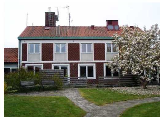
Foto 2014, baksidan på den äldre byggnaden.
