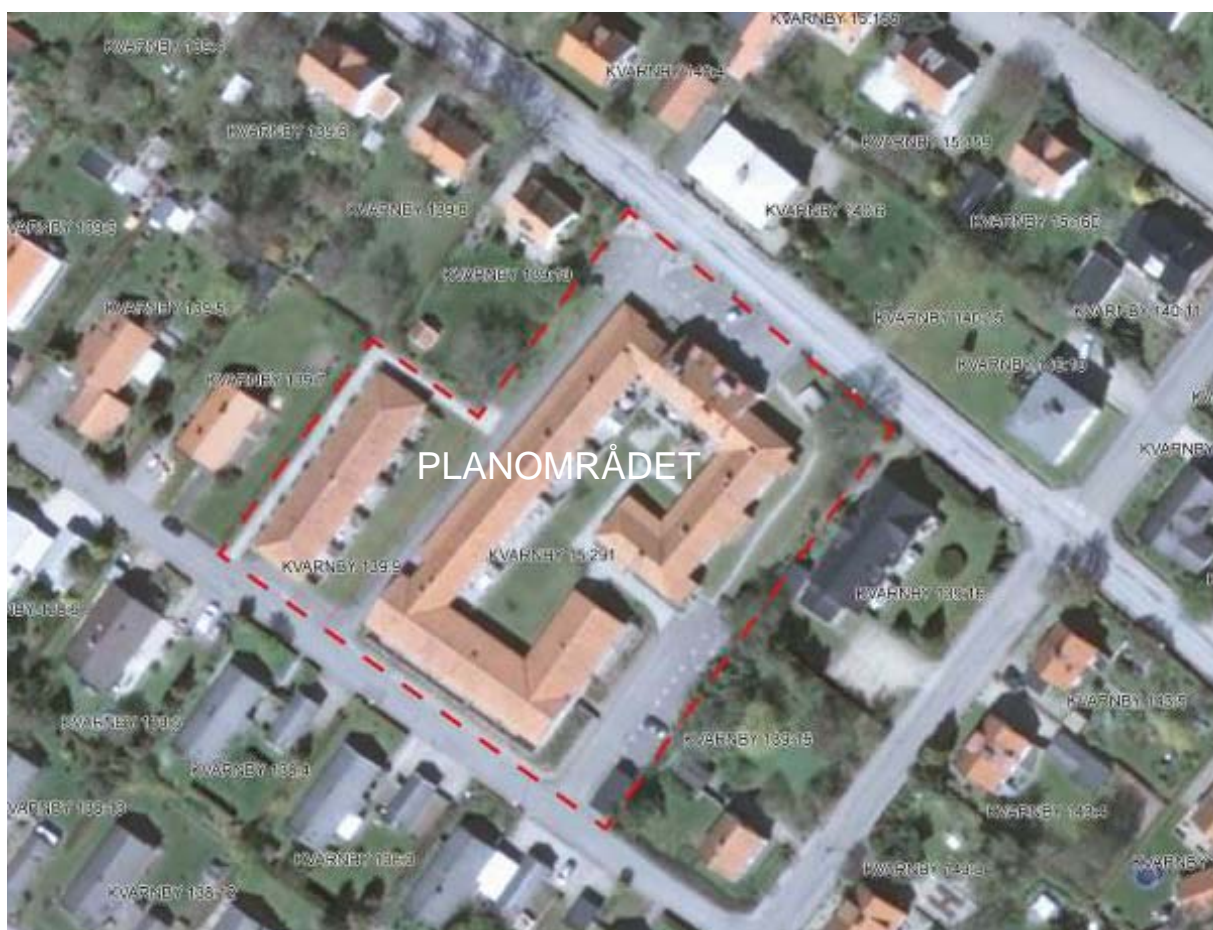
Flygfoto 2012 med planavgränsning markerat med rödstreckad linje. Planområdet utgörs av fastigheterna Kvarnby 139:9 (i nordväst som angränsar till Långgatan i sydväst) och Kvarnby 15:291 (som angränsar till Långgatan i sydväst och Seymours väg i nordost).
