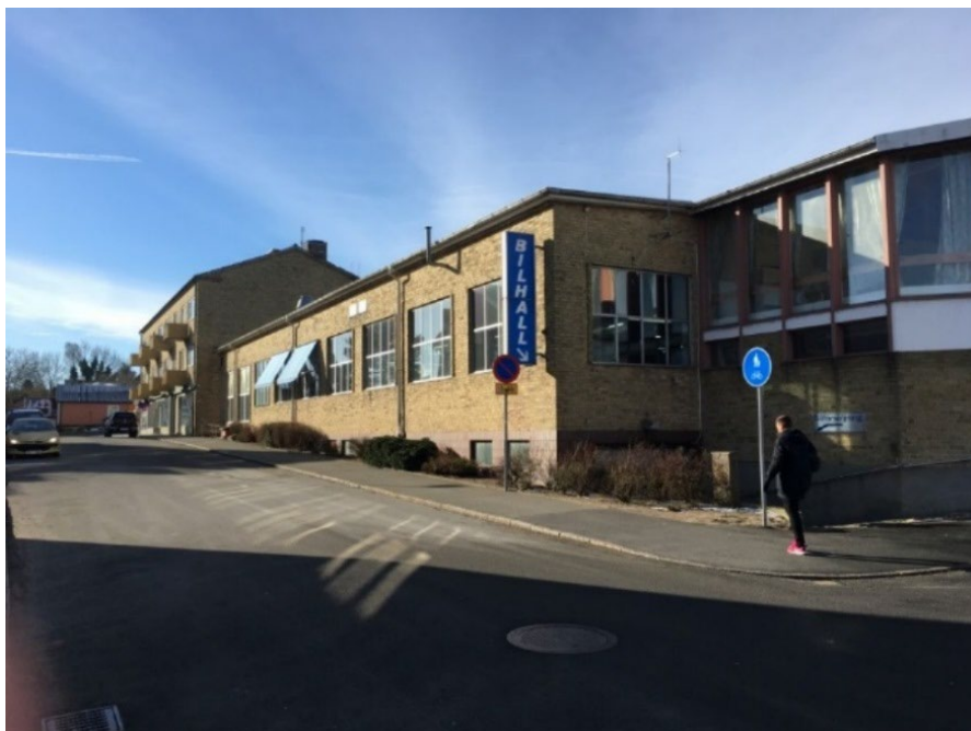
Bilhallen mot Fredsdalsgatan är klädd med samma gula tegel som bostadshuset på samma fastighet
