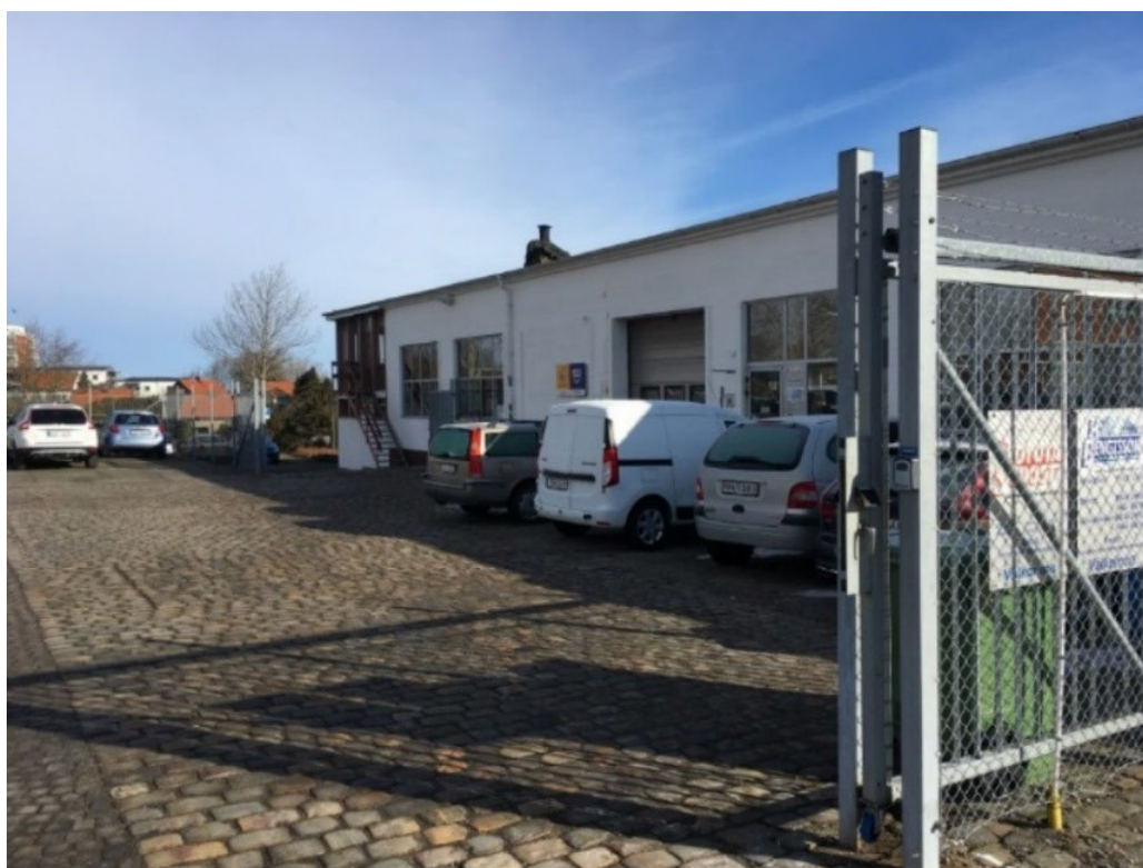
Bilservicehallen mot gården. Byggnaden har en stomme av betong och putsad fasad mot gården. Byggnadsarean är 910 kvm.
