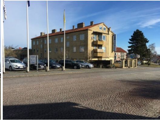
Befintligt bostadshus på Vipan 2
