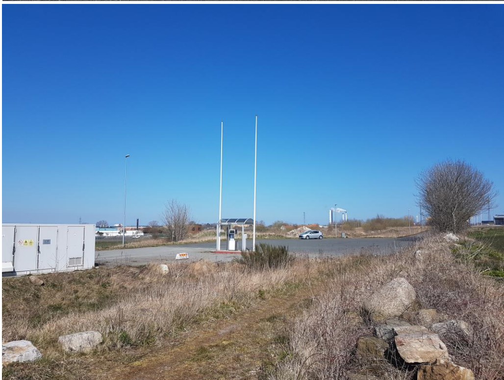
Bilder som visar planområdet i den sydöstra delen där det finns en mindre drivmedelstation.
