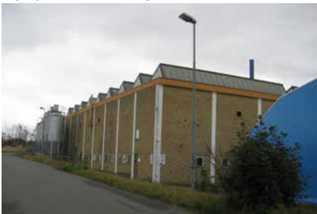
Lyckebyhuset (B) med sina karaktäristiska gula tegelväggar och triangelformade ljusinsläpp på taket.
