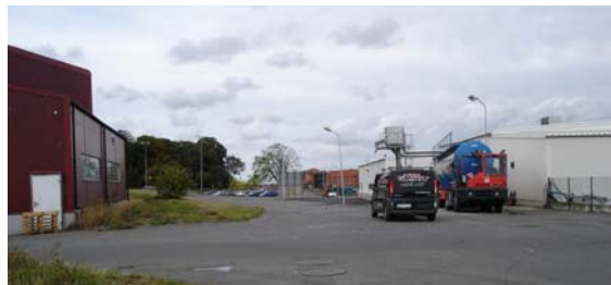
Appelkvists kylhus t.v (1) mot Svartehallsvägen, här emellan löper mark planlagd för järnväg
