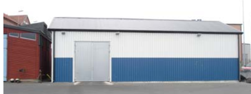
Kylhus tillhörande Skillinge Fiskimpex AB uppfört vintern 2013 med tillfälligt bygglov t.om 2015-05-21
