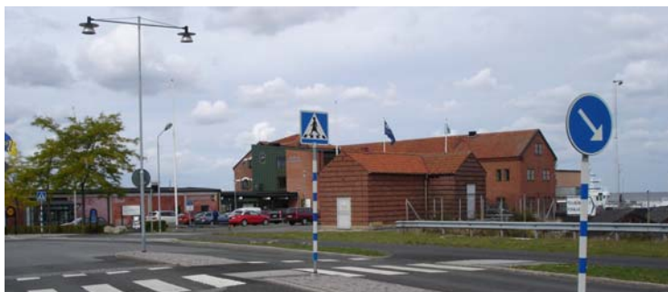
Marint centrum och transformatorstation från 1936/1964 sett från Branteviksvägen
