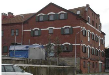
Fasad mot norr. Foto oktober 2013
