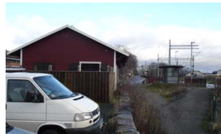
Godsmagasinet gavel mot väst. Söder om fastighetgränsen mot järnvägsområdet löper ett gångstråk mellan parkeringen och perrongen
