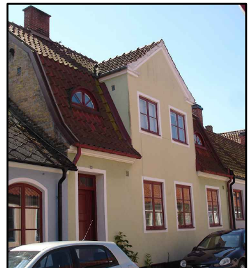
Herden 5/St. Rådmanngatan 22 Huset är ett envåningshus med frontespis, stänkputsfasad i grönt och tjärad stänkputssockel. Fönsterna är rödbruna med spröjs och består av sex stycken rutor. Ursprungsörrar, samma färg som fönstren. Taket är sadeltak med enkupigt tegel.
