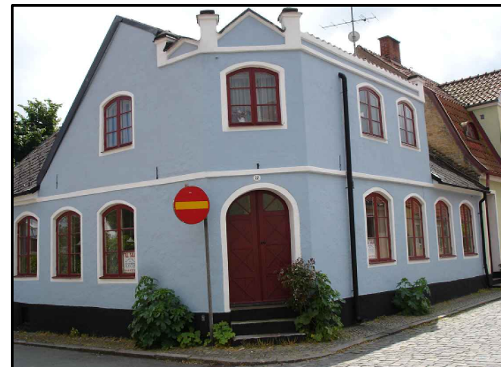
Herden 5/Östergatan 13 Huset är ett tvåvåningshus med stänkputsfasad i ljusblå kalkfärg med tjärad stänkputssockel. Fönstren är rödbruna med spröjs och består av sex stycken rutor. Ursprungsörrar i samma färg som fönstren. Takbeläggning är av tjärpapp.
