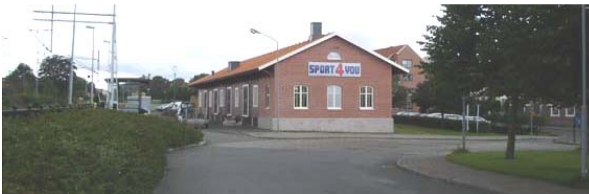
Godsmagasinet fasad i tegel som vetter mot stationen, planområdet sett från ost. Foto september 2011
