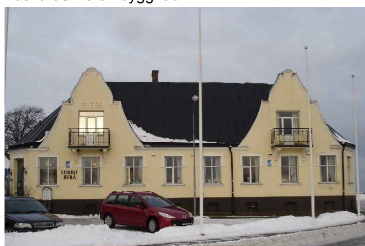
Foto: Fasad mot sydost. December 2010. Evelina Simonsson
