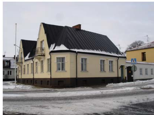
Huvudbyggnaden och det ena uthusets fasad mot Strandvägen
