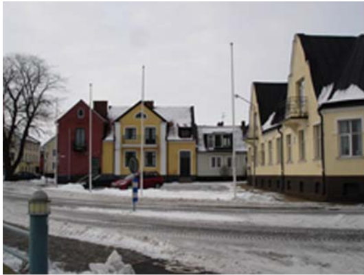
Torgyta vid Strandvägen i sydöst. Till höger gamla Turistbyrån som detaljplanen berör. I fonden gamla Tullhuset (röd gavel)
