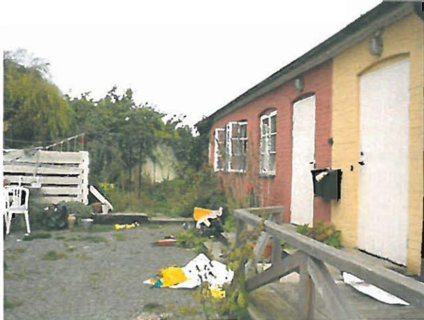
Gårdshuset med sina båda entréer. Byggnaden har ett yttertak av plåt.
