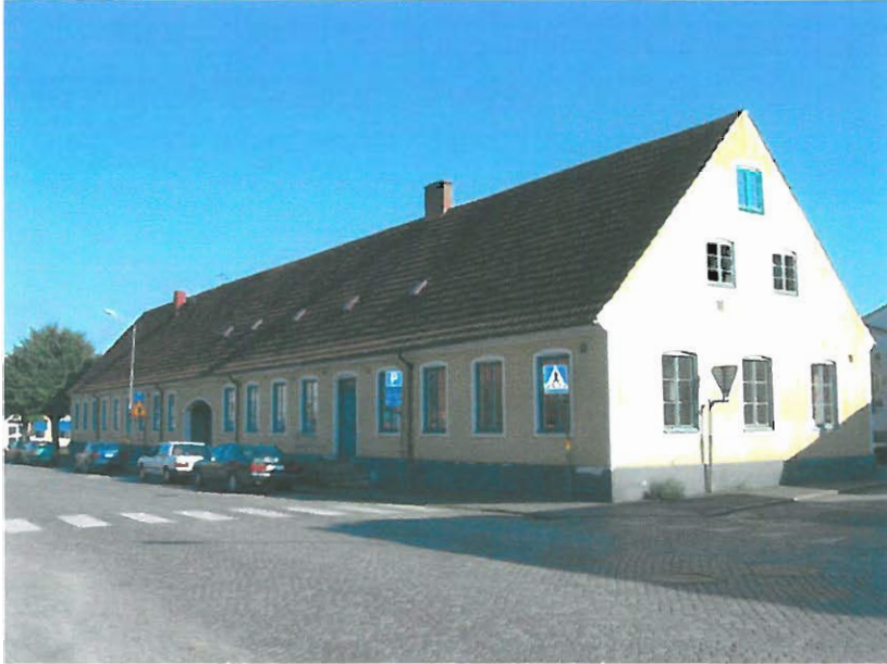
Gulputsad fasad mot Storgatan.
