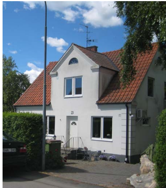
Fastigheten Stiby 1:90 i norra delen av planområdet.
